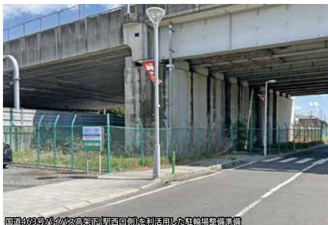
国道463号バイパス高架下(駅西口側)を利用した駐輪場整備準備
