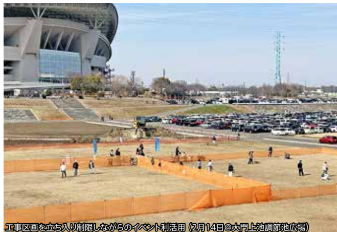
工事区画を立ち入り制限しながらのイベント利活用(2月14日@大門上池調節池広場)
