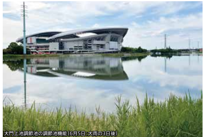
大門上池調節池の調節池機能 (6月5日:大雨の3日後)
