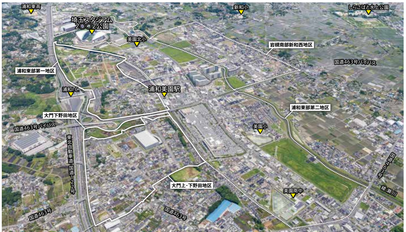
浦和美園駅周辺の概況（撮影：2022年6月）
