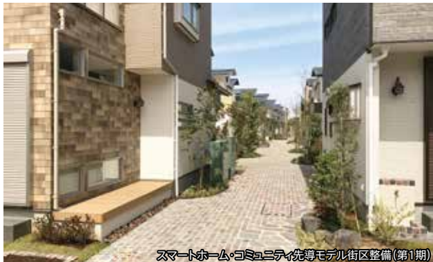
スマートホーム・コミュニティ先導モデル街区整備(第1期)
