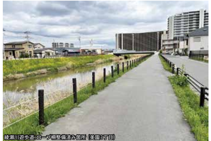
綾瀬川遊歩道:ロープ柵整備済み箇所(美園3丁目)
