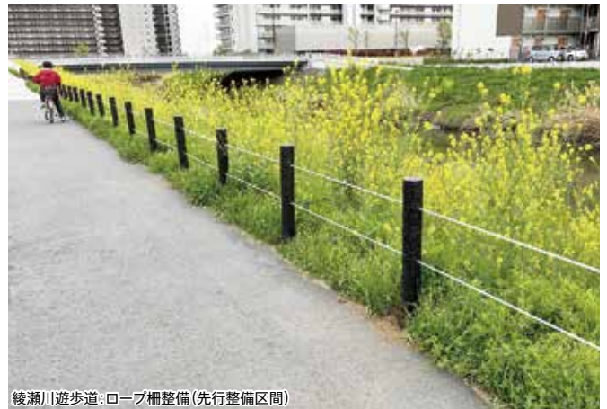
綾瀬川遊歩道:ロープ柵整備(先行整備区間)
