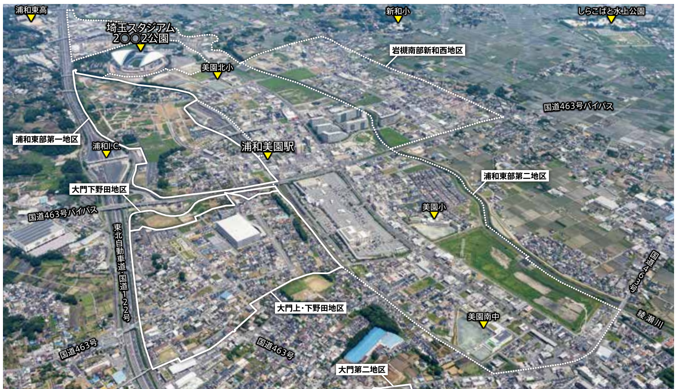
浦和美園駅周辺の概況（撮影：2020年6月）
