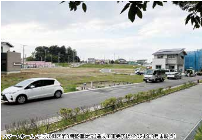
スマートホーム・モデル街区第3期整備状況(造成工事完了後:2021年3月末時点)
