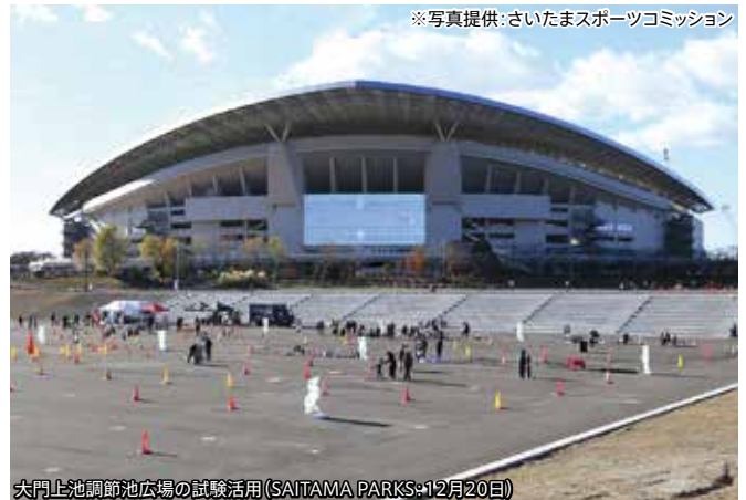
大門上池調節池広場の試験活用(SAITAMA PARKS:12月20日)
