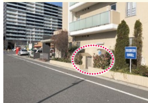
【事例】建物と同素材で囲いを設けつつ緑化修景
