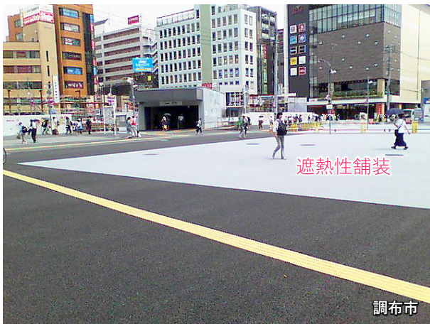
環境に配慮した路面舗装の事例
