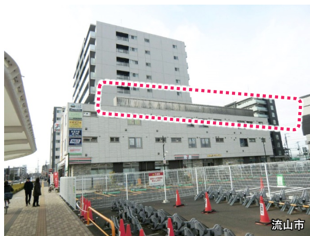
屋上の建築設備を目立ちにくく修景した事例
