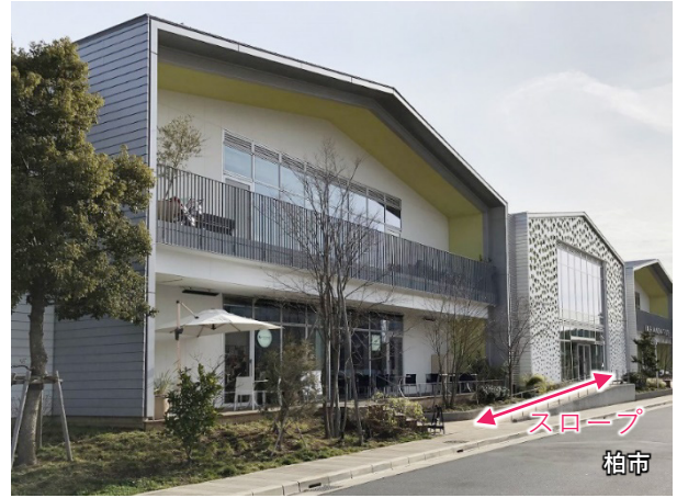
スロープを設置した事例
