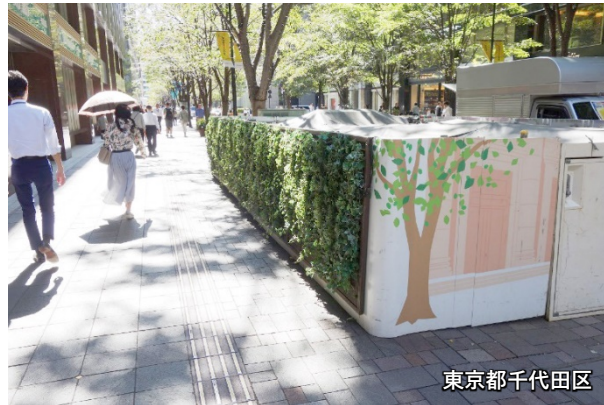
仮囲いを緑化等で修景した事例
