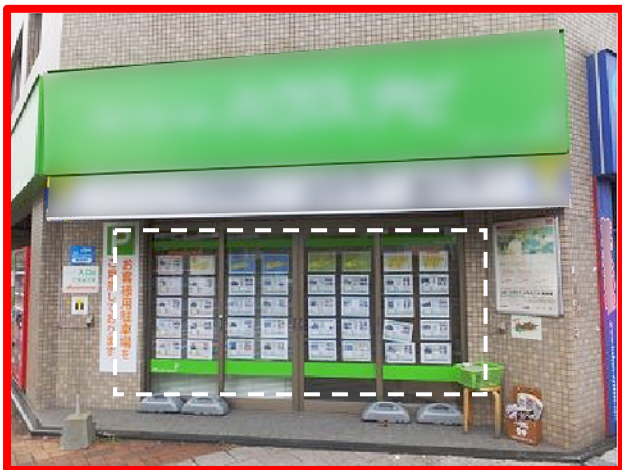
過度な窓面広告物により建物内部が見えない事例 【好ましくない事例】
