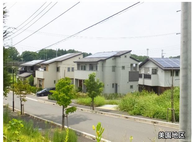
太陽光パネルが、屋根色と調和した事例
