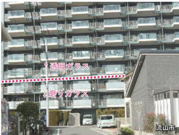
低層階のベランダのガラスを磨りガラスとした事例 (透明ガラス部分と比べ、景観に溶け込んでいる)
