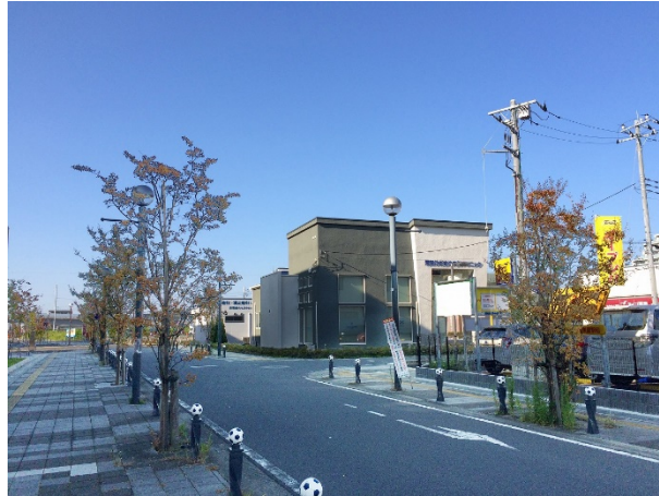
スタジアム参道の裏側から配線して、メイン道路沿いには建柱していない事例
