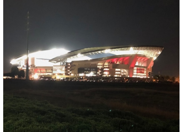
壁面を赤い光で照らし、 シンボル空間を演出した事例
