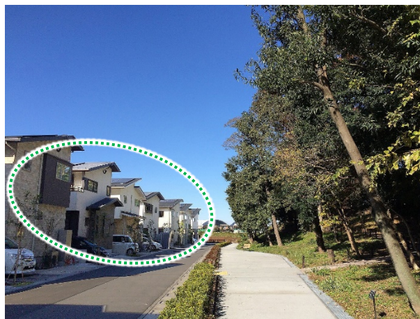
自然環境を阻害しない色彩を用いた事例
