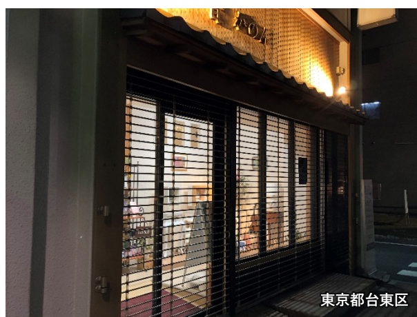
パイプシャッターを用いた事例
