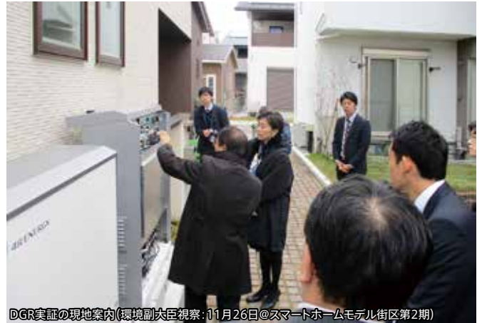
DGR実証の現地案内(環境副大臣視察:11月26日@スマートホームモデル街区第2期)
