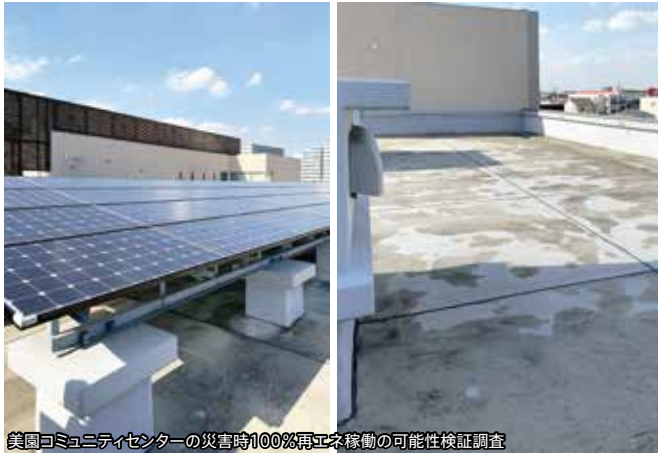
美園コミュニティセンターの災害時100%再エネ稼働の可能性検証調査
