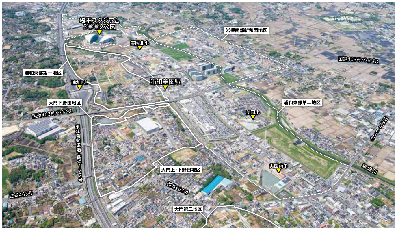
浦和美園駅周辺の概況（撮影：2019年4月）
