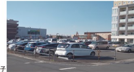
浦和美園駅東口駅前の様子
