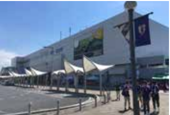
参道の起点となる浦和美園駅舎
