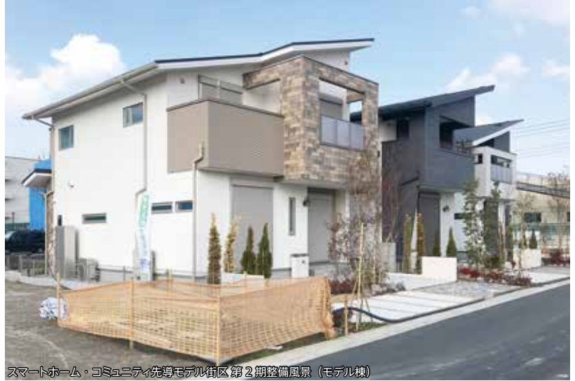
スマートホーム・コミュニティ先導モデル街区第2期整備風景 (モデル棟)
