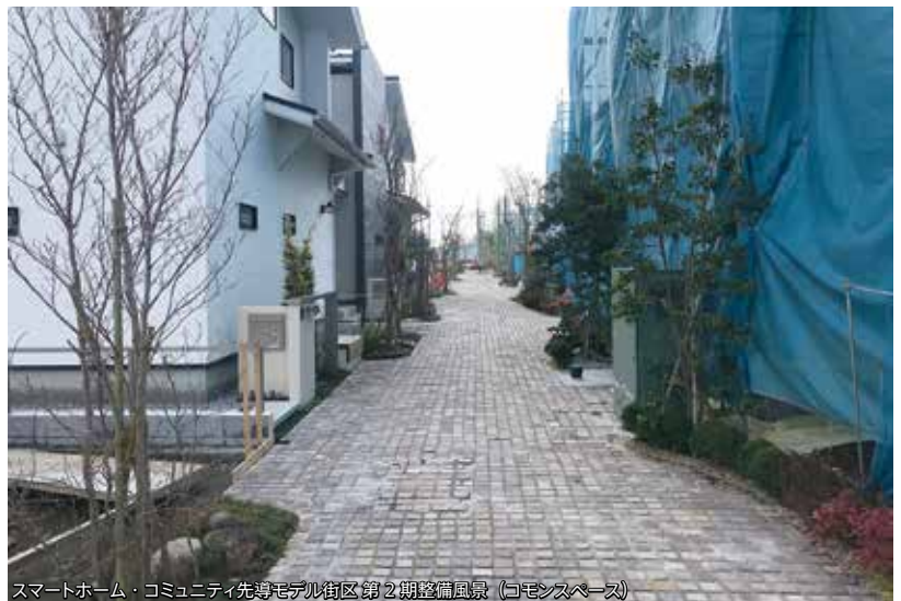
スマートホーム・コミュニティ先導モデル街区第2期整備風景 (コモンスペース)
