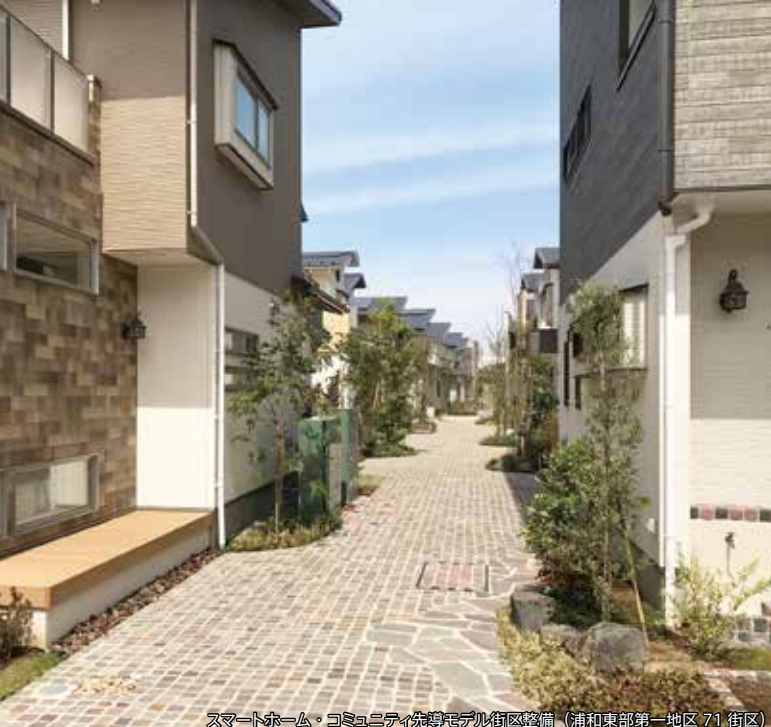
スマートホーム・コミュニティ先導モデル街区整備（浦和東部第一地区 71 街区）
