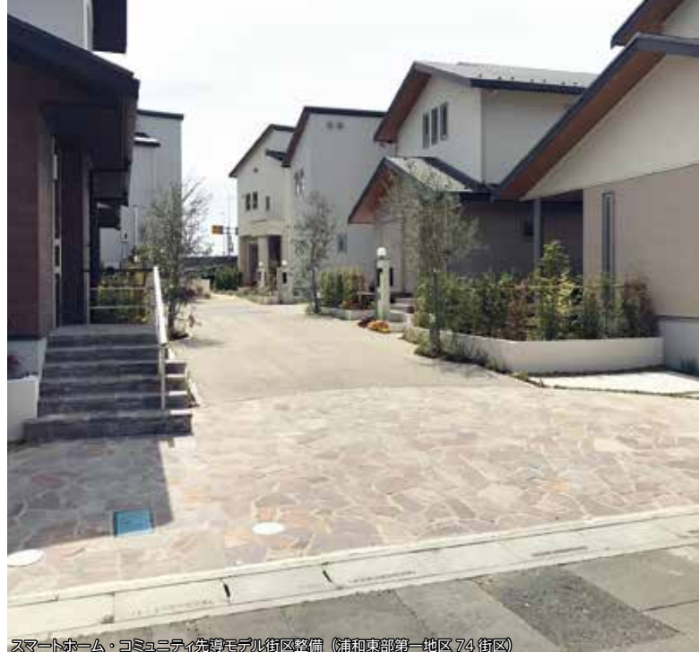
スマートホーム・コミュニティ先導モデル街区整備（浦和東部第一地区 74 街区）
